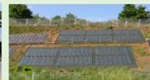
法面を活用した 設置
